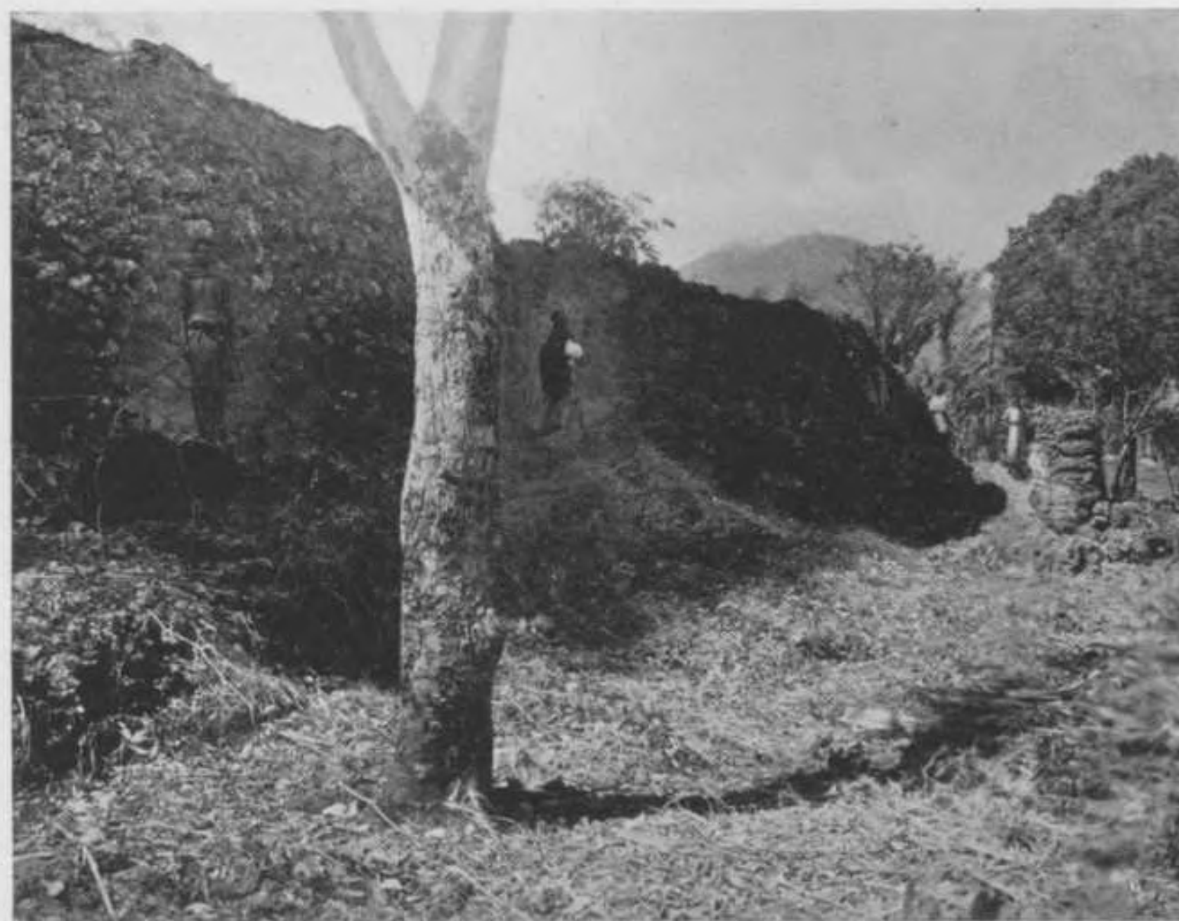
176 Verteidigungsmauer um Falulotto (s. Abb. 173)
